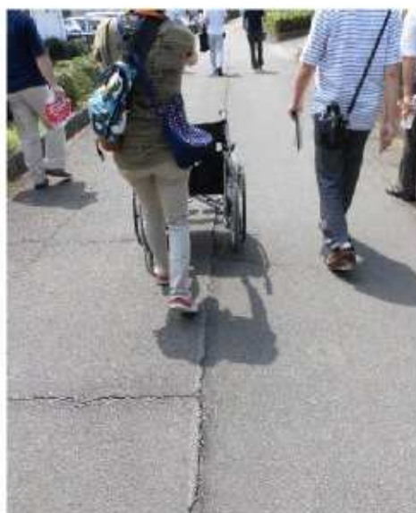
路面状況の確認
